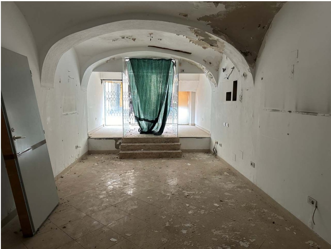
FOTO 2 – INTERNO LOCALE PRINCIPALE
