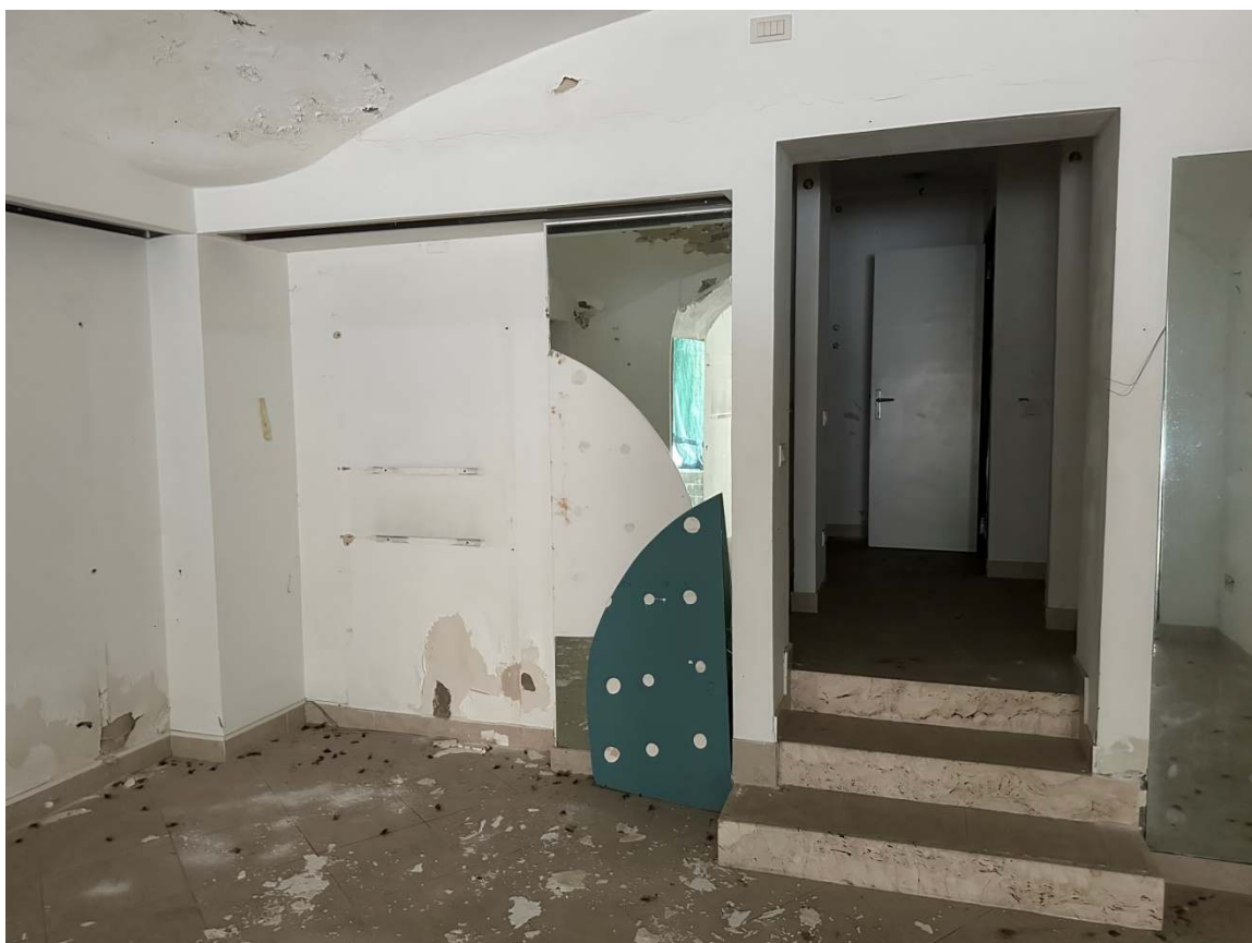
FOTO 5 - INTERNO LOCALE PRINCIPALE
