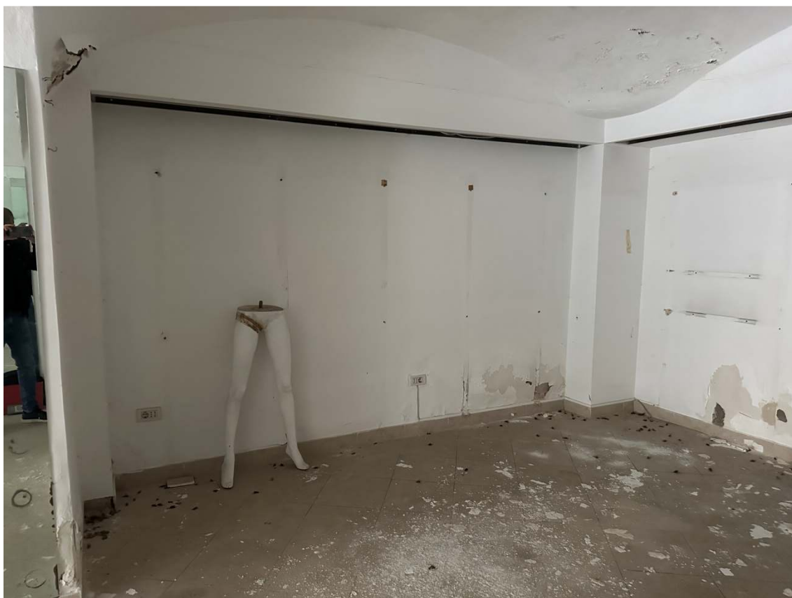
FOTO 4 - INTERNO LOCALE PRINCIPALE
