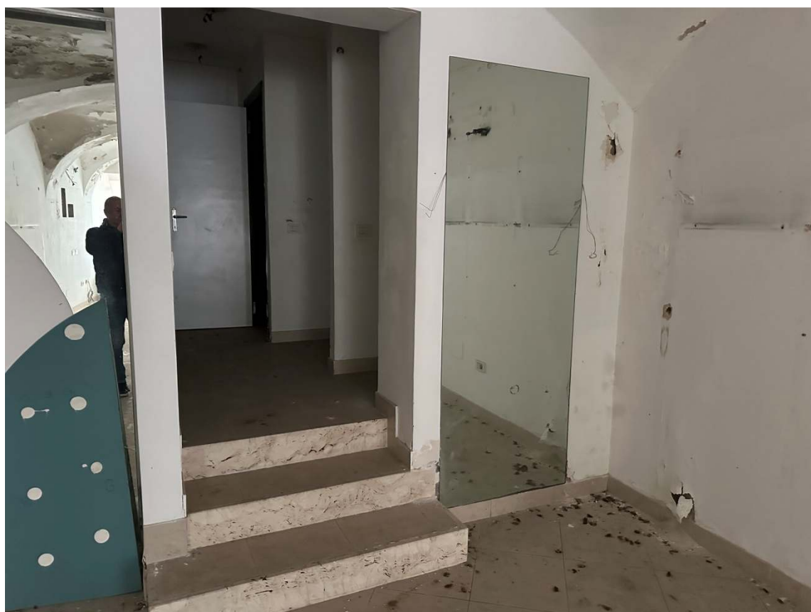
FOTO 6 - INTERNO LOCALE PRINCIPALE
