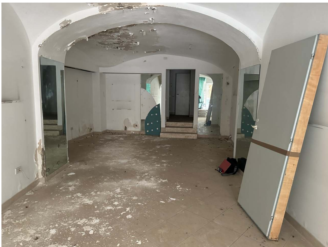
FOTO 3 - INTERNO LOCALE PRINCIPALE
