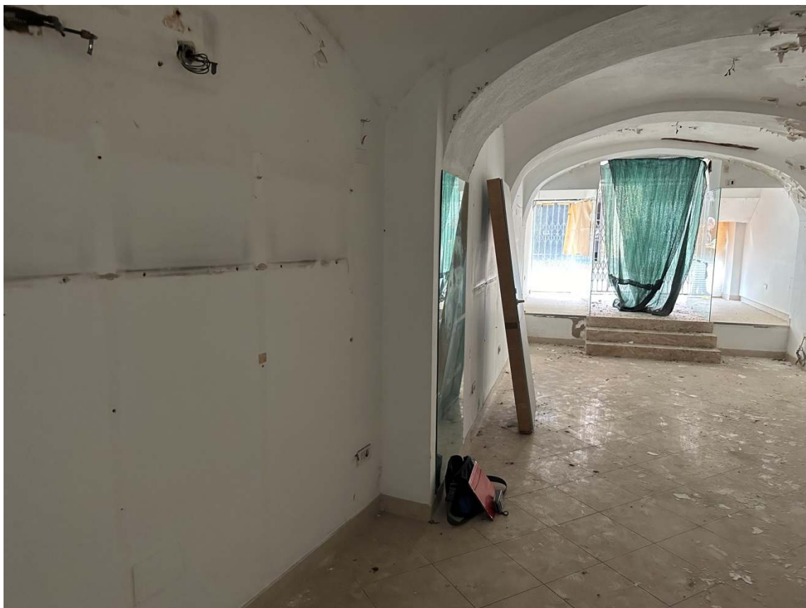
FOTO 7 INTERNO LOCALE PRINCIPALE
